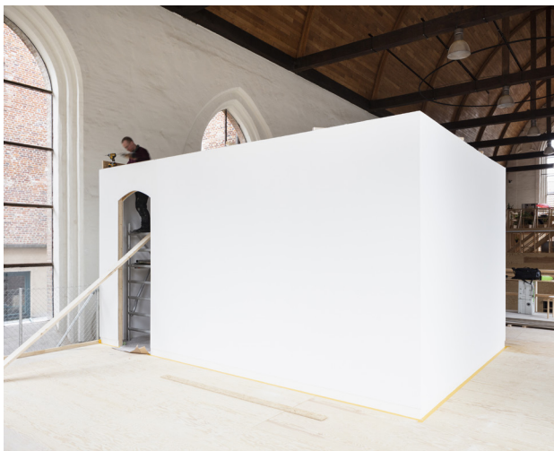
Constructie van Spatial Intervention KHG#03 (paviljoen en brug), juni 2020. Ontwerp door Olivier Goethals.
