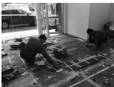
Wai Kong Lui and crew verwijderd de vloer bij PI, New York, 30 mei 2017.
